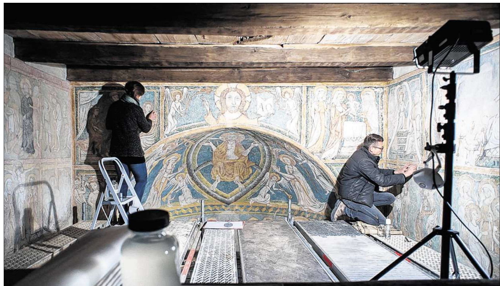
Oben auf dem Gerüst leuchten die beiden Restauratoren die Wandmalereien mit einem Scheinwerfer für ihre Arbeit aus.
